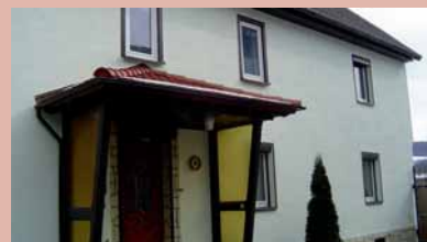
Ein schönes Haus mit gepflegter Fassade und neuen Fenstern ...
